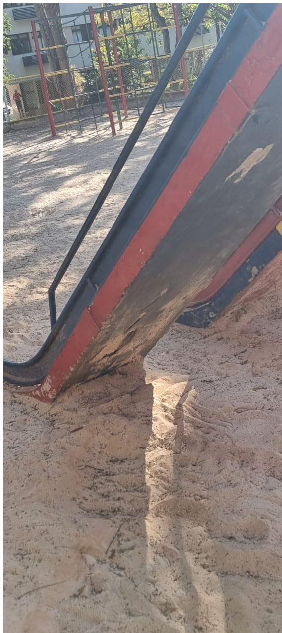
Foto 7: Estrutura metálica corroída em escorregador.
