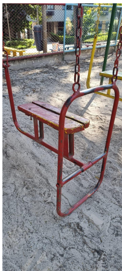
Foto 3: Correntes metálicas corroídas em estrutura de balanço
